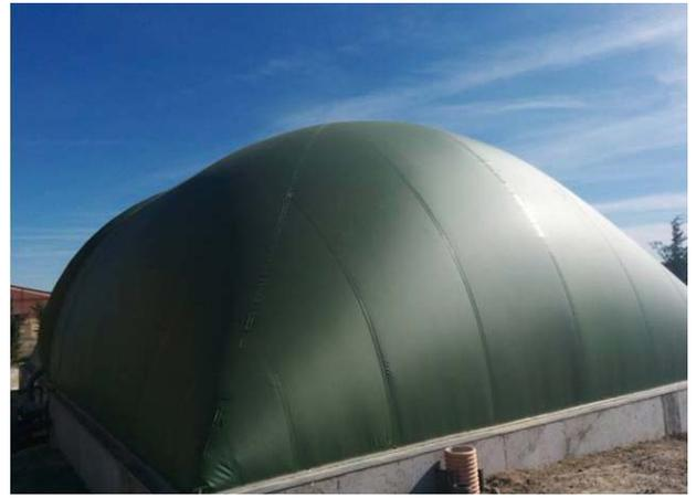
La digestión metanogénica o biometanización de la materia orgánica, es un proceso microbiológico anaeróbico que degrada la materia orgánica y produce como uno de sus productos finales un combustible renovable: el BIOGÁS
